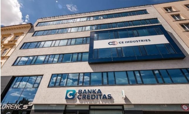
Budova S9 Praha Florenc
