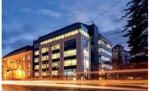
Administrativní budova v Olomouci
